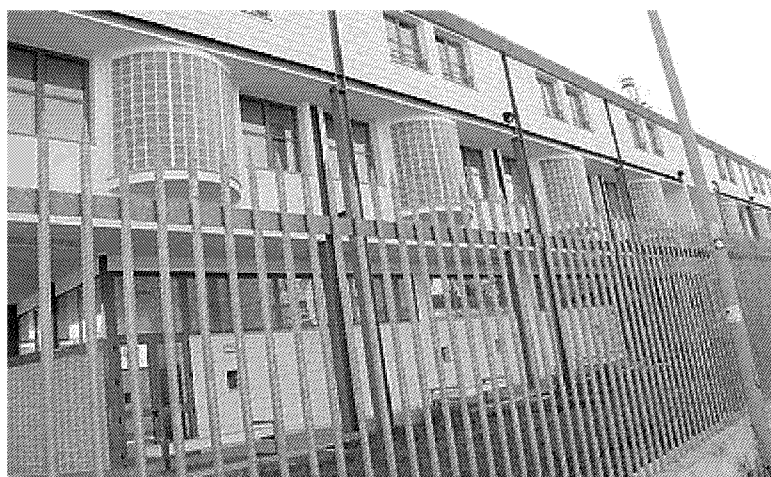
TUTTO SBARRATO La struttura di via del Mezzetta
